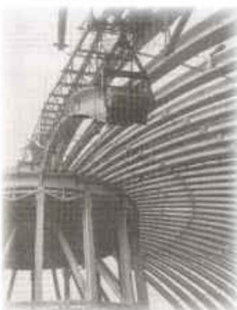
машинама. Тако је направљен модел у размери 1:10 који је испитан за сва оптерећења за које хала није могла бити прорачуната.
